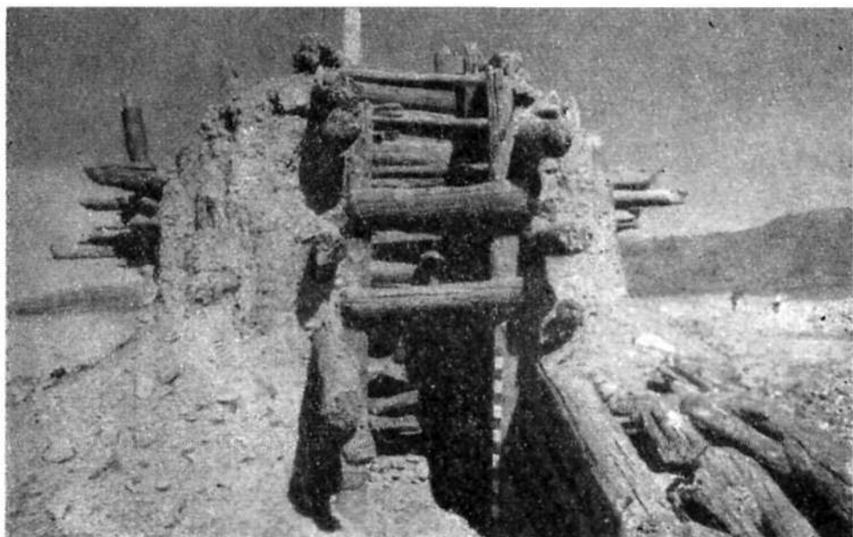
Рис. 42. Восточный фасад — вход в усыпальницу.
