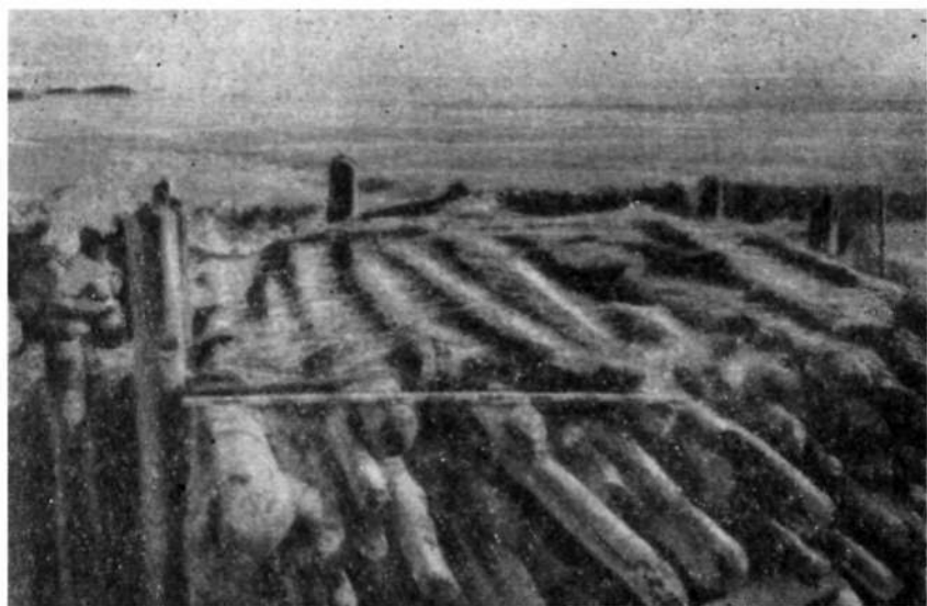
Рис. 12. Общий вид кровли; камышовое покрытие на бревнах наката.
