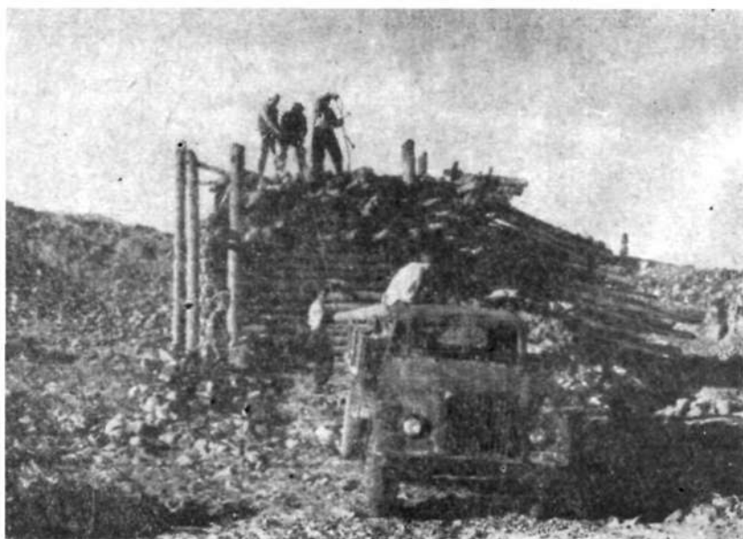
Рис. 23. Разборка и перевозка усыпальницы.
