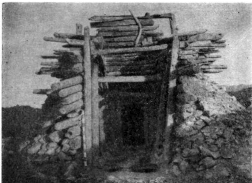
Рис. 18. Восточный фасад — вход в усыпальницу.
